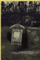
Einsenken der Kugel in die vorbereitete Baugrube.
